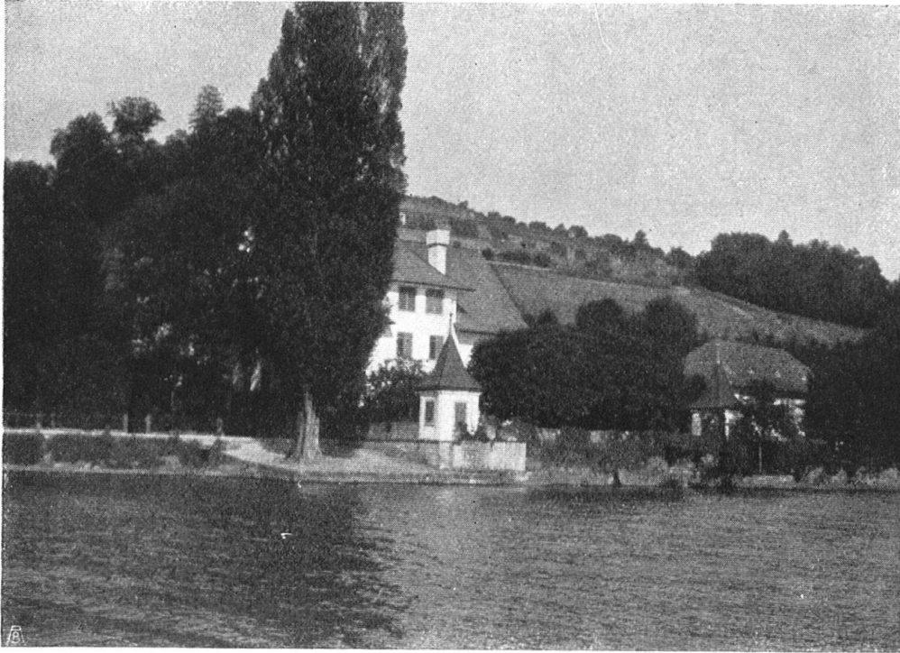
Abb. 26. Die Schipf in Herrliberg. Baumwuchs und Weinlaub rahmen Haus und Ufermauern ein; so erscheint der altzürcher Landsitz in freier Harmonie von Baukunst und Natur. Aufnahme von Dr. H. Peter, Zürich. — Fig 26. La «Schipf» à Herrliberg. Des vignes et des groupes d'arbres majestueux encadrent naturellement les bâtiments et les murs de grève, et cette antique maison de campagne zurichoise constitue avec son entourage un ensemble parfait d'architecture et de paysage.
