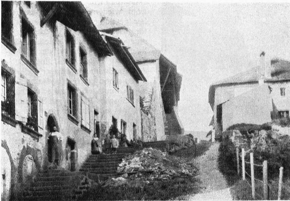
Abb. 3. Aufstieg in der Altstadt (Südseite links, Nordseite rechts). Aufnahme von Dr. E. Blank, Erlach. Fig. 3. La rue qui monte à l'ancienne ville. Les façades de gauche sont tournées vers le nord.
