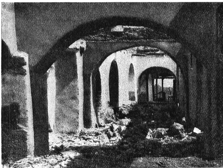
Abb. 2. Laubengang der Südseite, nach dem Brande (1915). Fig. 2. Les arcades, côté sud, après l'incendie de 1915.
