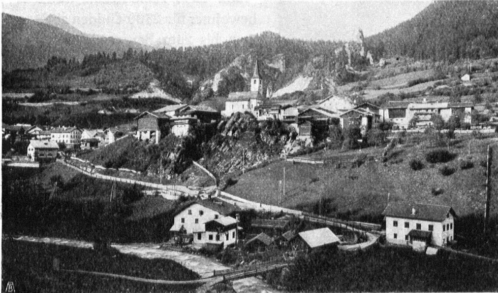
Abb. 1. Gesamtansicht von Filisur, mit Ruine Greifenstein im Hintergrunde. Fig. 1. Vue générale de Filisur, à l'arrière-plan la ruine de Greifenstein.
