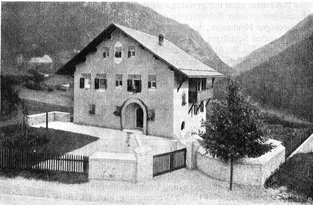
Abb. 18. Bahningenieur-Haus der Rhätischen Bahn; ein, der heimischen Bauweise trefflich angepasster, künstlerisch origineller Bau von Architekt Lorenz der Rh. B. — Fig. 18. Maison de l'ingénieur des chemins de fer Rhétiques. Construction originale et d'un goût artistique dont le style s'accorde parfaitement avec l'architecture indigène. Architecte M. Lorenz.
