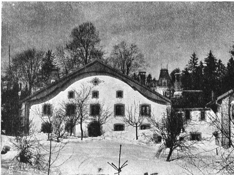
Abb. 16. Gegenbeispiel. Falsche Anwendung der Giebelverschalung des Bernerhauses auf das flache keltoromanische Haus. Eines der letzten jurassischen Bauernhäuser in La Chaux-de-Fonds. — Fig. 16. Mauvais exemple. Application fautive du pignon de la maison bernoise à un bâtiment keltoroman. Une des dernières constructions rustiques de La Chaux-de-Fonds.
