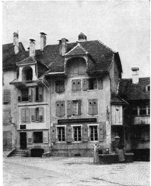
Abb. 10. Haus in Moudon. Die Ausgestaltung des Daches und der Nebengebäude schliesst sich an die bäuerliche Bauweise an. Aufnahme von E. Buri, Basel. — Fig. 10. Maison à Moudon. Les formes du toit et des dépendances rappellent l'architecture rustique.
