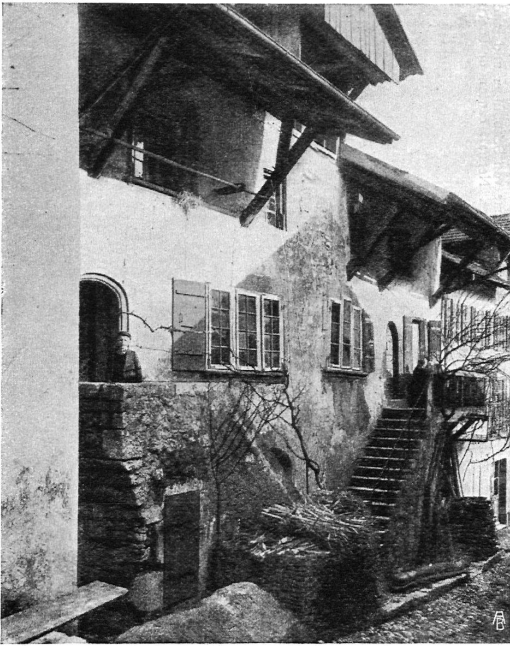
Abb. 9. Steinbauten in Twann, mit weiten, dem Holzbau entstammenden Dachausladungen. Besondere Ausbildung der Traufe und des Estrichloches. Aufnahme von R. Minder, Biel. — Maisons en pierres à Douanne. Les avant-toits, très larges, sont un souvenir des anciennes constructions en bois. Remarquer le développement qu'ont pris les gouttières et les combles.
