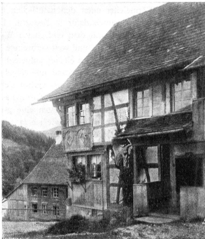
Abb. 1. Im „Erleholz“, bei Bernhardzell (Kanton St. Gallen). Fachwerkhaus mit Holzverschalten, zum Teil ausgeschnittenen Partien. Aufnahme von Schobinger und Sandheer, St. Gallen. — Fig. 1. A Erleholz, près Bernhardszell, canton de St-Gall. Construction en colombage avec quelques parties boisées.
