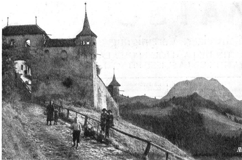
Fig. 2. Les remparts et la porte de la ville; à l'arrière-plan, le Moléson. Cliché Jullien frères, Genève. — Abb. 2. Blick auf Ringmauern und Stadttor; in der Ferne der Moléson.
