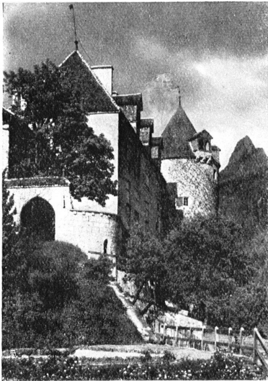
Fig. 9. Une vue de l'imposant château de Gruyères qui a été sauvé de la destruction grâce à l'initiative privée. Cliché Jullien frères Genève. — Abb. 9. Blick auf das stattliche Schloss, das nur durch privates Eingreifen vor Jahrzehnten der drohenden Zerstörung entging.
