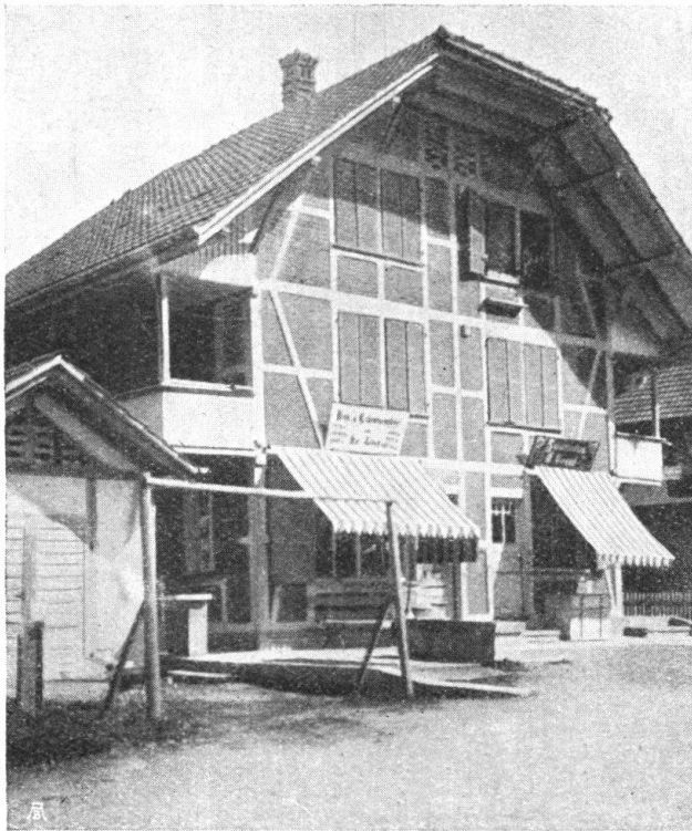
Abb. 16. Seftigen. Gegenbeispiel. Neubau beim Bahnhof. Rechts davon stehen noch einige ähnliche Bauten. — Fig. 16. Mauvais exemple. Bâtiment nouveau près de la gare. D'autres maisons analogues se voient à droite de celle-ci.
