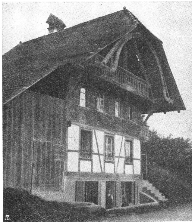
Abb. 11. Heimberg. Haus mit Ständerwand über Fachwerk. Die Konstruktion des sonst immer verschalten Giebels ist hier sichtbar. — Fig. 11. Heimberg. Murs en pans de bois dans la partie inférieure en poutres verticales dans la partie supérieure. La construction du pignon est ici à découvert.
