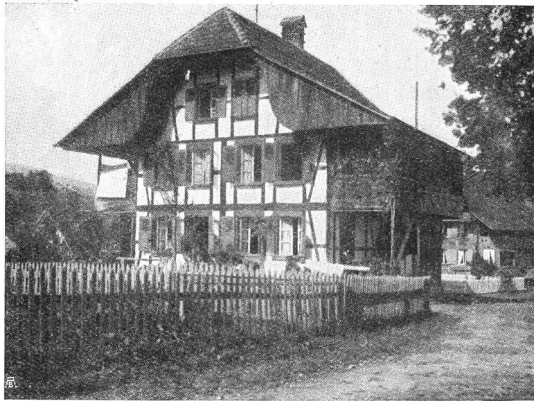
Abb. 18. Wahlen bei Thierachern. Fachwerkhaus. Fig. 18. Wahlen, près Thierachern. Construction en pans de bois.
