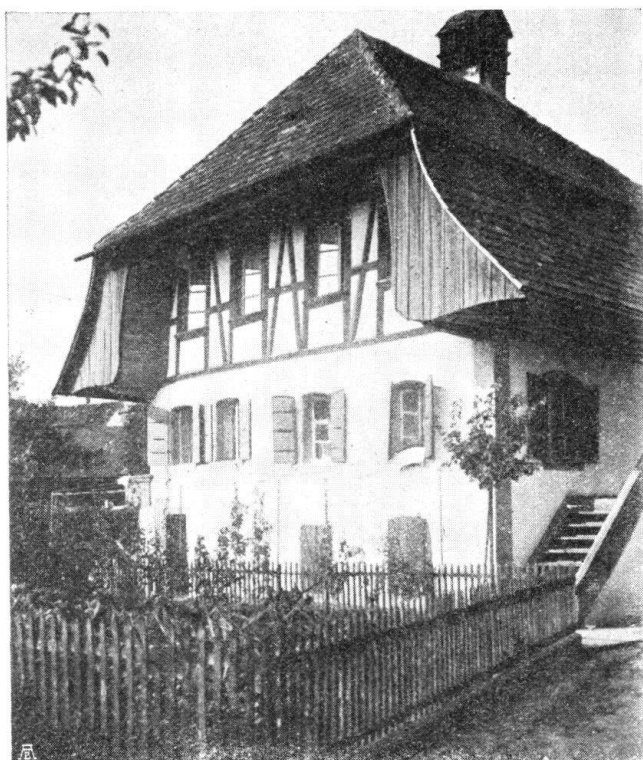
Abb. 13. Seftigen. Massives Haus mit Fachwerkgiebel. Fig. 13. Seftigen. Murailles massives en bas, murs en pans de bois dans le haut.
