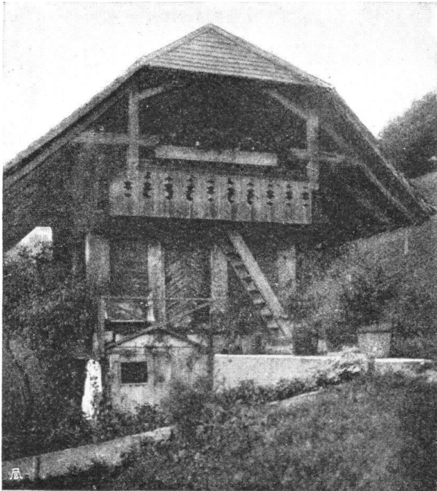
Abb. 1. Heiligenschwendi. Speicher. Fig. 1. Heiligenschwendi. Grenier.
