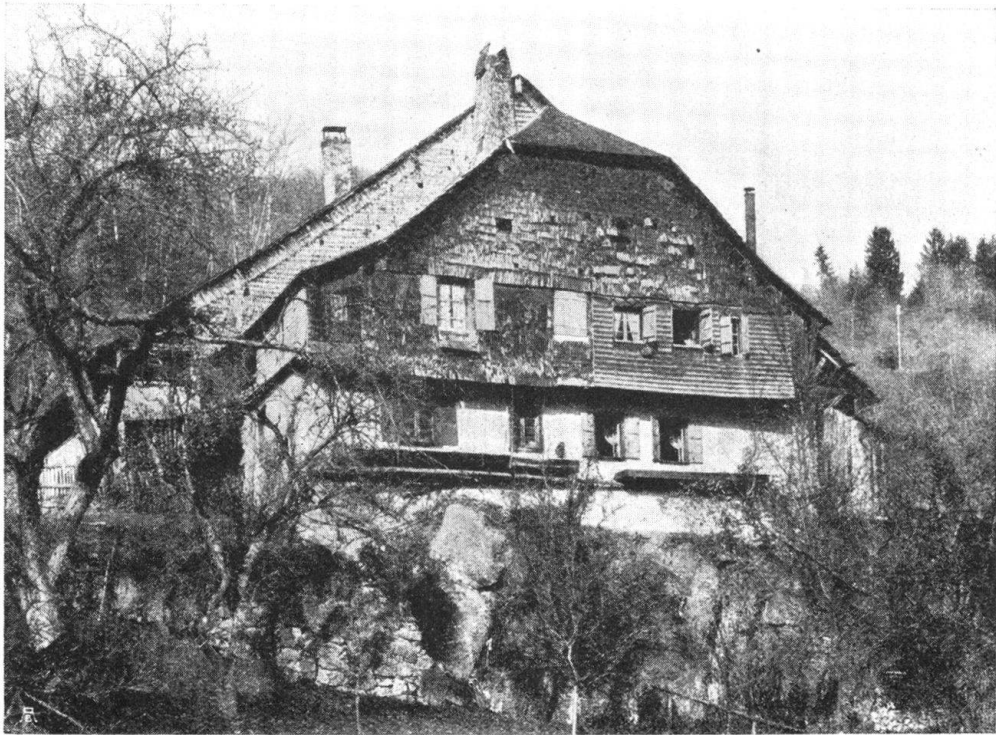
Fig. 6. Maison aux Monts-de-Corsier, tavillonée à la fribourgeoise. Abb. 6. Haus in Monts-de-Corsier, nach Freiburger Bauweise verschindelt.
