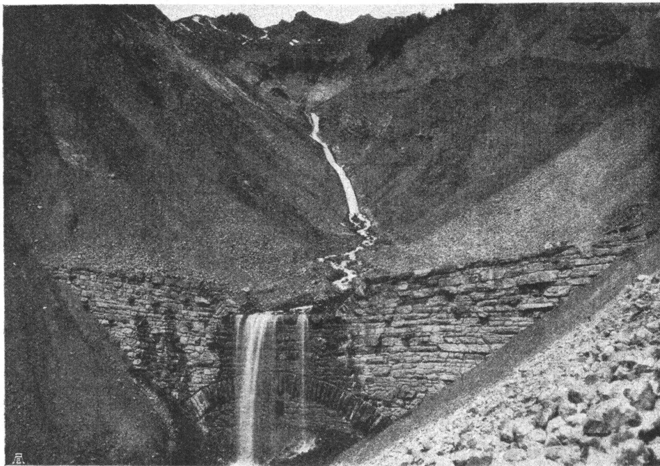
Abb. 4. Lamm- bach bei Brienz. Sperre V und Schale. Fig. 4. Correction du Lamm- bach, près Brienz. Barrage V et bassin.
