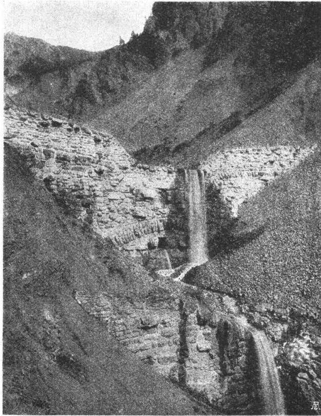
Fig. 3. Correc- tion du Lamm- bach, près Brienz. Barrages I et II.
