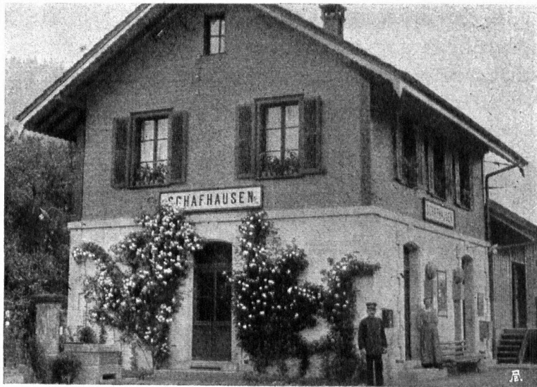
Abb. 1. Station Schafhausen an der Linie Burgdorf-Thun. Eine sonst reizlose Mauer ist mit Rosenspalier und Blumenstöcken anmutig geschmückt. — Fig. 1. Gare de Schafhausen sur la ligne Berthoud-Thoune. Une muraille qui serait sans cela nue et monotone a été gracieusement décorée de rosiers grimpants, et de fleurs aux fenêtres.
