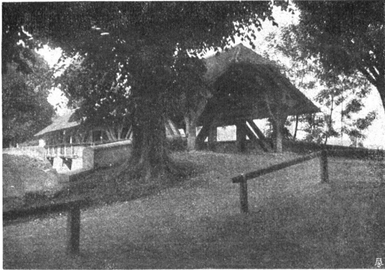
Abb. 18. Innere Wynigenbrücke. Noch heute von stattlichen Bäumen flankierter Osteingang der alten Holzbrücke. — Fig. 18. Le pont d'Innern Wynigen. L'entrée orientale de l'antique pont de bois est ornée encore aujourd'hui d'un groupe d'arbres majestueux.
