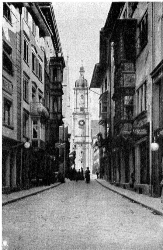
Abb. 7. Strassen an deren Ende mit kluger Berechnung als Zielpunkt ein starkes Architekturmotiv gesetzt ist (St. Gallen). Aufnahme der Edition Photoglob, Zürich. — Fig. 7. Rues aménagées de telle sorte que leur perspective se termine par un fond d'architecture monumentale (Saint-Gall).
