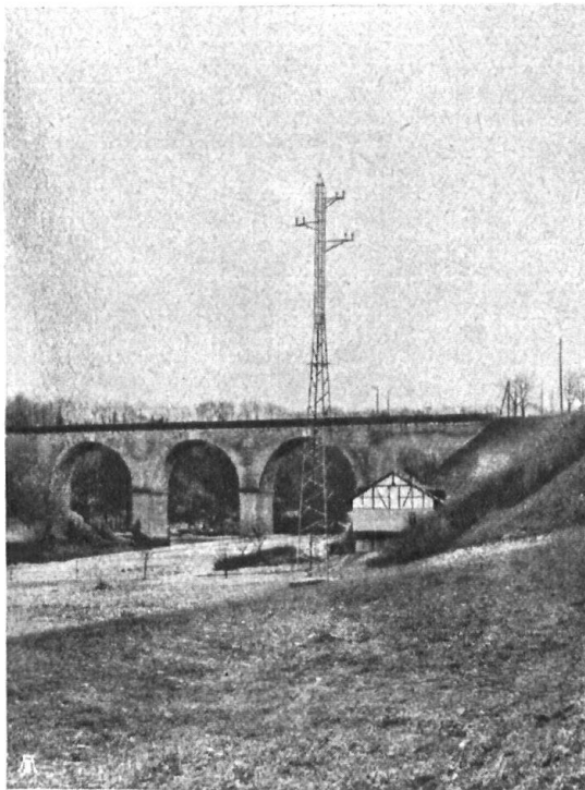
Abb. 9. Oberspannungsleitung an der Tiefenau- brücke bei Bern. Aufnahme St. v. Jasienski, Bern. Fig. 9. Conduite électrique près du pont de Tiefen- au, environs de Berne.
