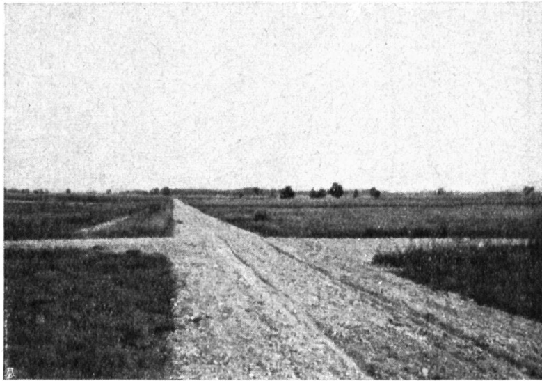
Abb. 13. Mit der Reisschiene „korrigierte“ Feldsträsschen bei Dübendorf, Kt. Zürich. Durch geeignete Baumpflanzungen könnte die Öde der Strasse behoben werden. Aufnahme von H. Straub. — Fig. 13. Chemin vicinal des environs de Dubendorf, «corrigé» à l'équerre. Une plantation d'arbres enlèverait un peu de sa sécheresse à ce paysage.
