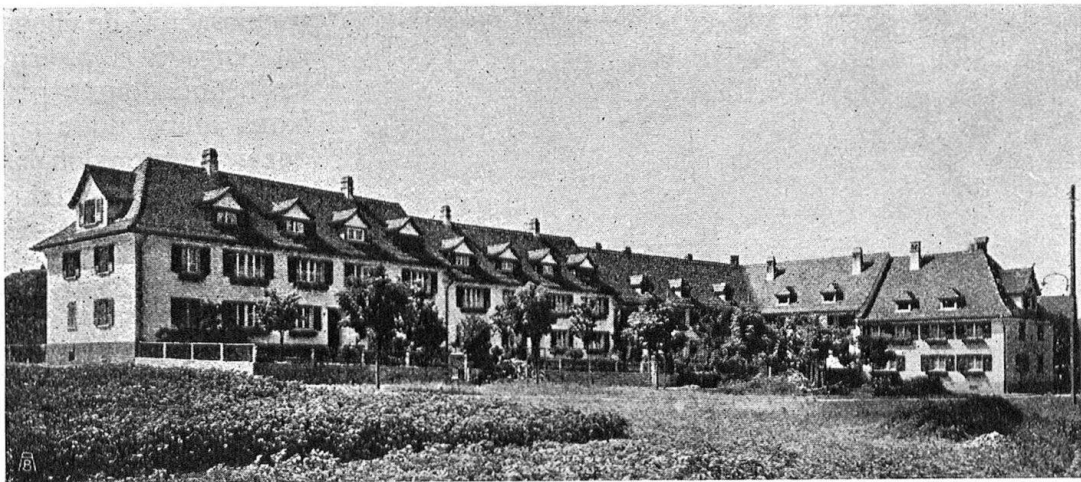
Abb. 11. Wohnkolonie der Fabrik Maggi, Kempptal. Arch. Prof. Moser, Zürich. Fig. 11. Habitations d'employés Maggi, à Kempptal. Architecte: M. le professeur Moser, à Zurich.
