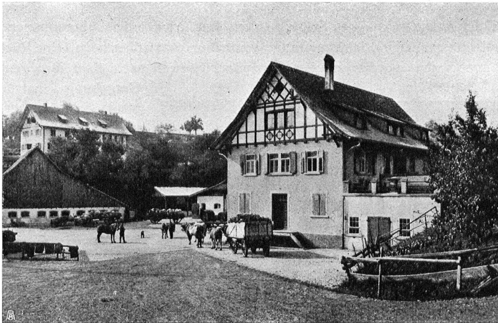
Abb. 7. Hof der Gutswirtschaft Maggi, Kempttal. Fig. 7. Cour des établissements agricoles Maggi, à Kempttal.
