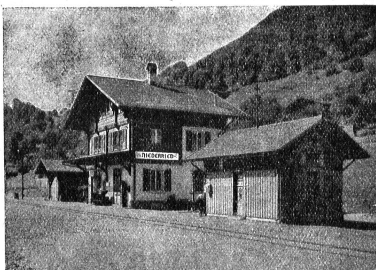
Station der Brienzerseebahn. Eternit-Doppeldach, kupferbraun
