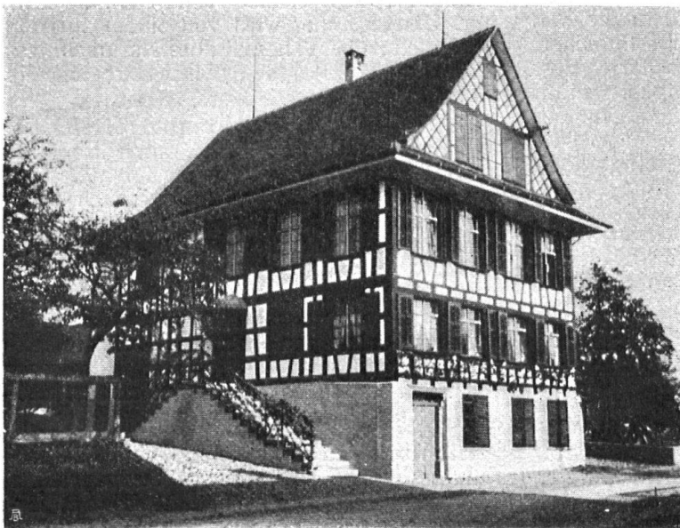
Abb. 16. Altes Schulhaus in Sulgen. Mit Sorgfalt renoviert. Aufnahme von Fr. Hoffmann, Coiffeur in Sulgen. — Fig. 16. Ancienne maison d'école à Sulgen, qui a été restaurée avec soin. Cliché de Fr. Hoffmann, coiffeur à Sulgen.
