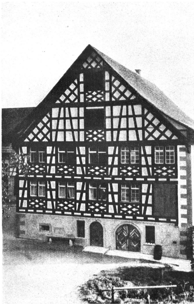
Abb. 18. Mühle Nussbaumen. Ein Beispiel sehr guter Renovation. Aufnahme von H. Gremminger-Straub, Amriswil. — Fig. 18. Le Moulin Nussbaumen. Exemple d'excellente restauration. Cliché de H. Gremminger-Straub, Amriswil.
