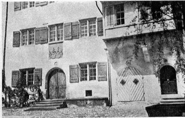
Abb. 2. Schlosshof Altenklingen. Blick vom Tor aus. Aufnahme von H. Gremminger-Straub, Amriswil. — Fig. 2. Cour du château d'Altenklingen, vue du portail. Cliché de H. Gremminger-Straub, Amriswil.
