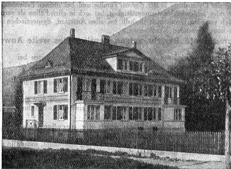
Wohnhaus in Ziegelbrücke Bedachung: Eternit-Doppeldeckung, kupferbraun
