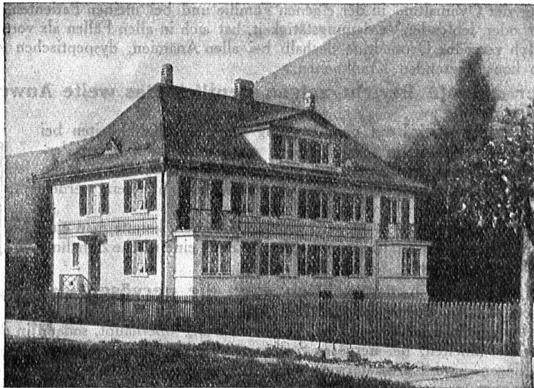
Wohnhaus in Ziegelbrücke Bedachung: Eternit-Doppeldeckung, kupferbraun
