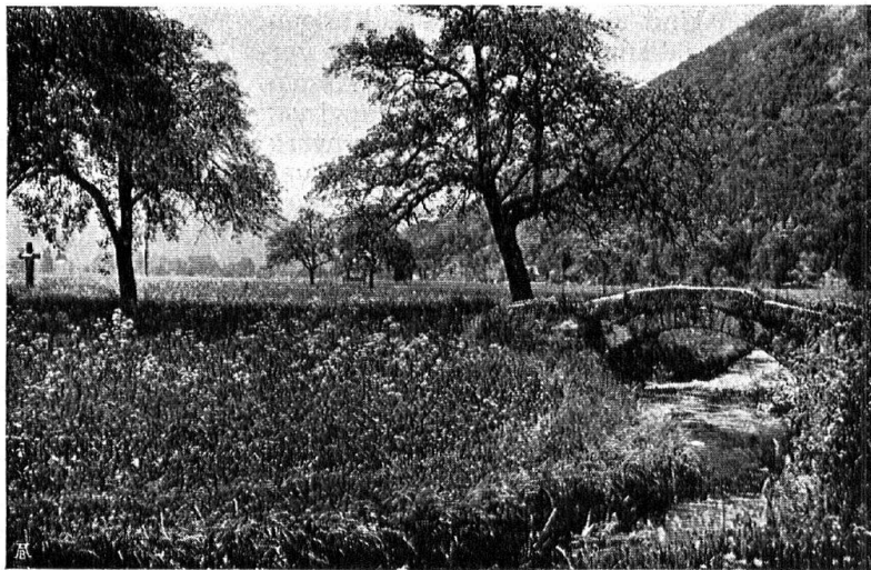
Abb. 27. Brückenbogen aus Granit-Findlingen am Mühlebach in Stans. 1922 unnötigerweise durch Sprengung beseitigt. — Fig. 27. Pont à arche en granit de blocs ératiques, à Stans, qui a été démoli sans utilité aucune en 1922.
