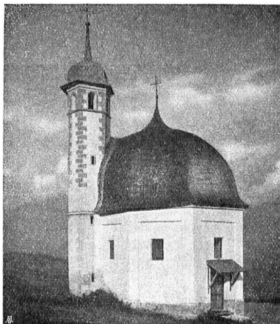
Abb. 5. Kirche zu Vattiz im Lugnez, Graubünden. Der Turmhelm ist mit hässlichen Blechtafeln gedeckt, während der zentrale Kirchenbau noch die alte Schindelbedachung zeigt. Aufnahme von K. Ramseyer. — Fig. 5. Eglise de Vattiz en Lugnez, Grisons. Le toit du clocher est couvert de plaques de tôles fort laides, tandis que le toit principal a gardé son revêtement ancien de tavillons. Cliché K. Ramseyer.
