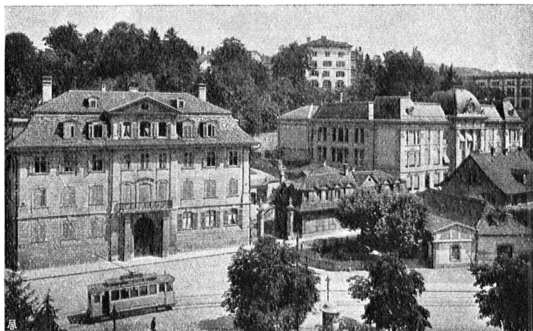
Abb. 17. Zürich. Verschiedene Deckungen. Links „Rechberg“ mit schön bewegtem Ziegeldach; rechts Musikschule: deckelartiges Schieferdach mit eingelegtem Muster. Aufnahme von Wehrli A.-G., Kilchberg. Fig. 17. Zurich. Toitures diverses, à gauche le „Rechberg“ avec un beau toit de forme élégante; à droite l'Ecole de musique, avec un toit d'ardoises. Cliché Wehrli A.-G., Kilchberg.
