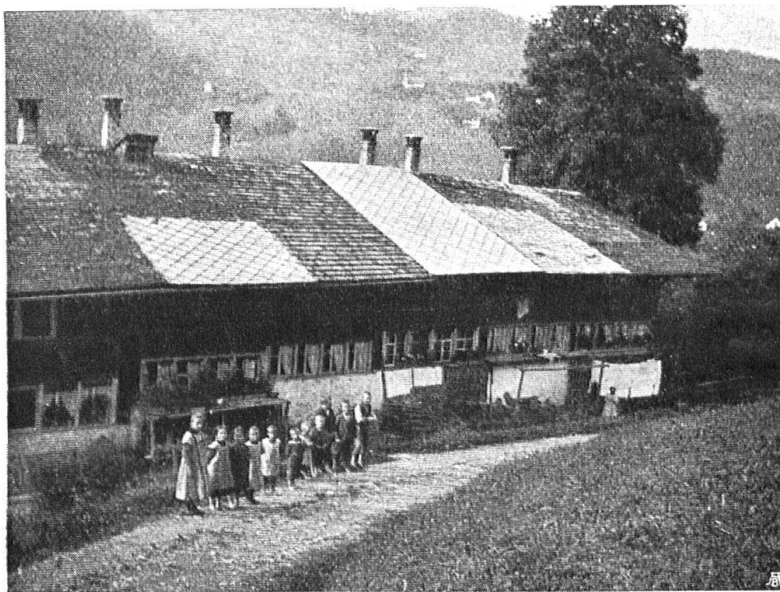
Abb. 11. Altes Oberländer Flarzhau (Hinterwies, Bauma). Das verunstaltete Dach ist auffällig durch seine Mischung von Schindeln, Ziegeln und Eternit. Aufnahme von K. Kilchsperger, Bauma. — Fig. 11. Ancien toit (Hinterwies, Bauma). Un mélange de bardeaux, de tuiles et d'éternite a fait de cette toiture une monstruosité, moderne. Cliché K. Kilchsperger, Bauma.
