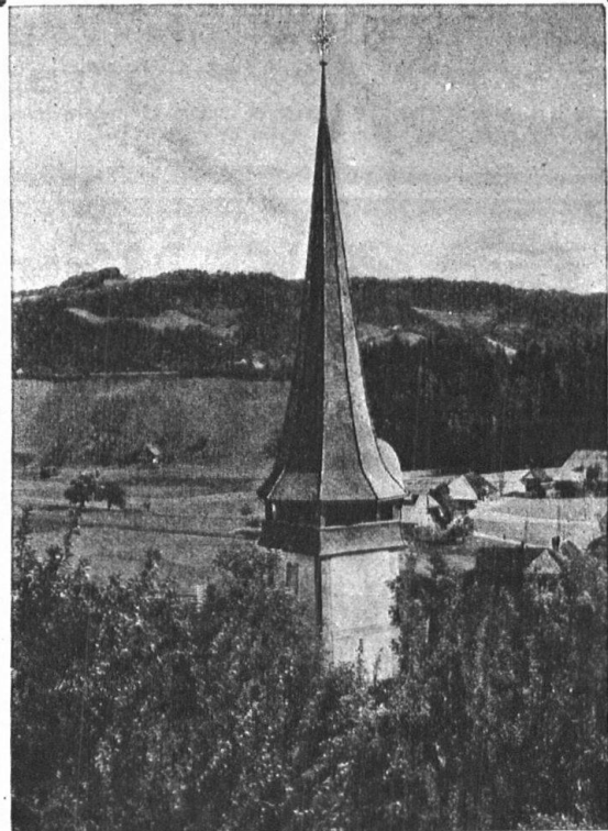
Kirchturm in Signau ETERNIT-DOPPELDACH, KUPFERBRAUN ETERNIT NIEDERURNEN
