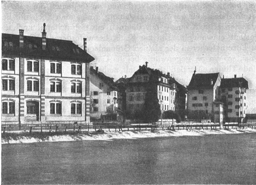
Abb. 5. „Im Zöppli“. Eine der schönsten Partien von Alt-Luzern, durch das neue Gewerbegebäude völlig verunstaltet. Der in Form und Farbe rohe Bau könnte und sollte umgestaltet werden! — Fig. 5. „Im Zöppli“. Une des plus belles parties de l'ancien Lucerne, complètement défigurée par le nouveau bâtiment des Arts et Métiers. Cette construction aussi laide par ses formes que par ses couleurs devrait absolument être transformée!
