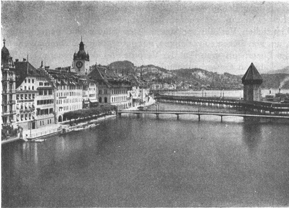
Abb. 4. Partie am Rathausquai. Mit Ausnahme des Erkers links, noch gut erhaltene Häuserpartie. Alte, der Gegend sich anschmiegende, Kapellbrücke. Neuer, die Landschaft trennender, gusseiserner Steg. Aufnahme von Wehrli A. G. Kilchberg. — Fig. 4. Le quai de l'Hôtel de ville. A l'exception d'un bâtiment moderne à encorbellement à gauche, on voit ici un groupe de maisons anciennes bien conservées. L'ancien pont de la Chapelle dont les formes sont en harmonie avec les lignes du paysage. A côté, un pont en fer, qui coupe brutalement le tableau. Cliché de Wehrli S. A. Kilchberg.
