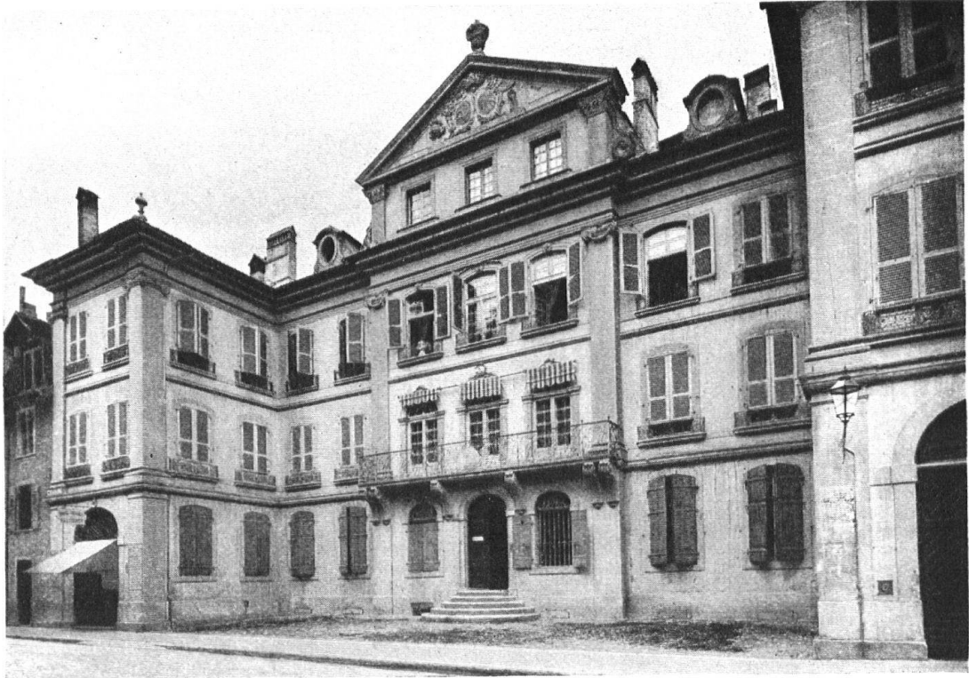
Fig. 6. Neuchâtel: Maison Erhard Borel. Construite en 1770. Joli fronton à emblèmes, type d'architecture française adaptée aux besoins du pays. — Abb. 6. Haus Erhard Borel, errichtet 1770. Hübscher plastisch geschmückter Giebel. Ein Stück französische Architektur, den örtlichen Bedingungen angepasst.
