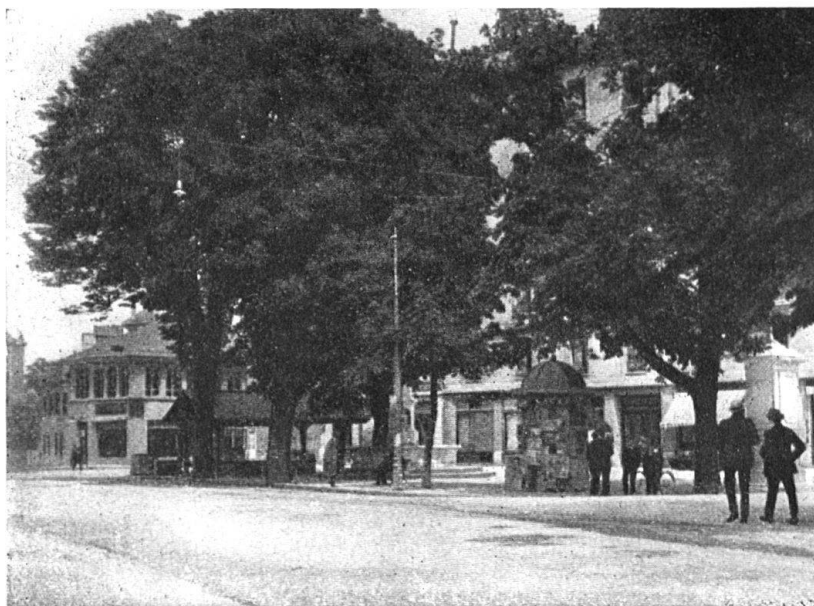
Abb. 7. Die «Place de la Navigation» in Genf, deren schöner Baumschmuck bedroht ist. Die hohen Kastanienbäume sollten erhalten werden! — Fig. 7. La place de la Navigation à Genève. Les beaux et grands marronniers sont menacés; espérons qu'on laissera à la Place ces arbres centenaires qui font son charme et sa fraîcheur.
