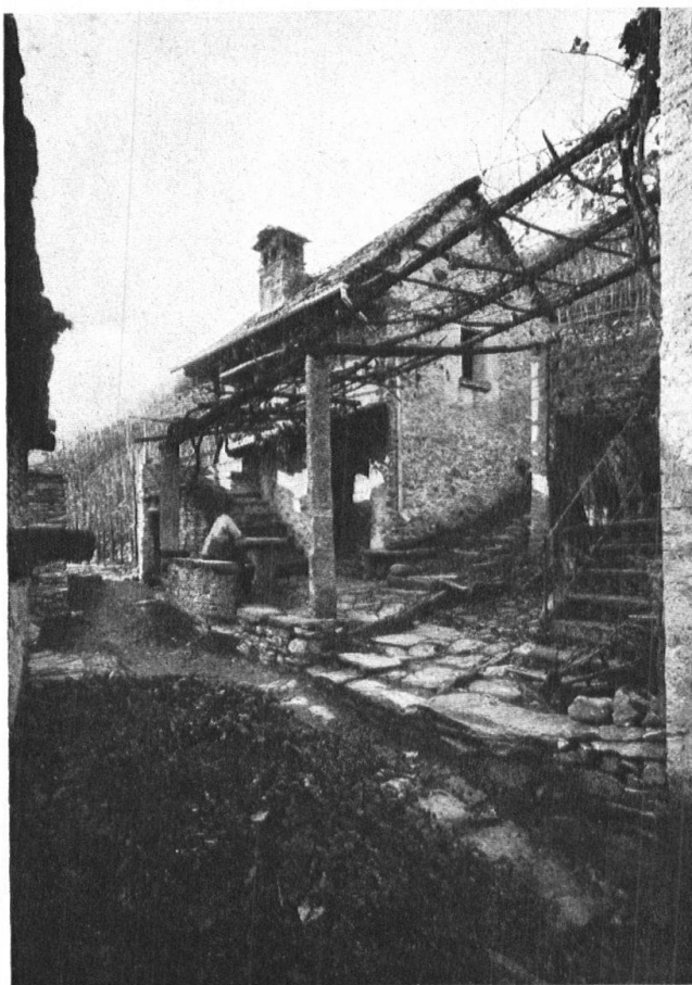
N° 9. Casa di viticoltori a Sementina. Esempio di adattamento ai bisogni locali. — Abb. 9. Haus eines Weinbauern zu Sementina. Beispiel der Anpassung an Bedingungen des Berufs und des Bodens.
