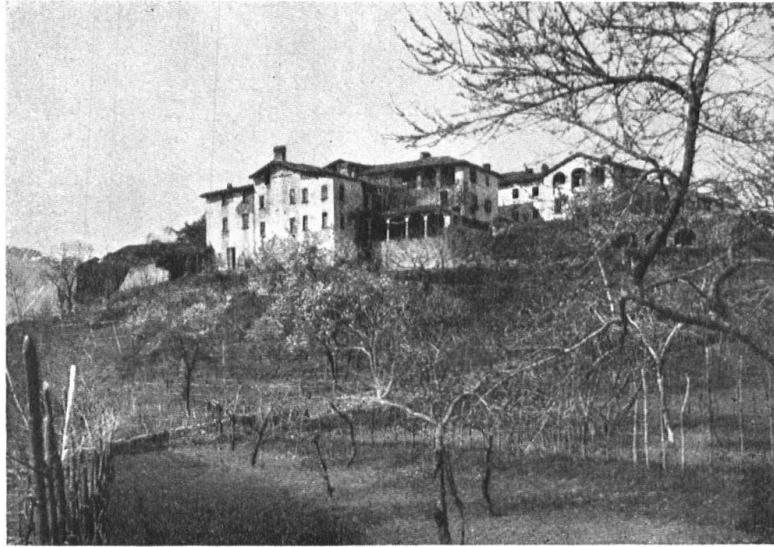
N° 6. Comano. Esempio di adattamento della linea del villaggio alla natura circostante. Abb. 6. Comano. Beispiel der Anpassung der Dorfgruppierung an die umgebende Natur.
