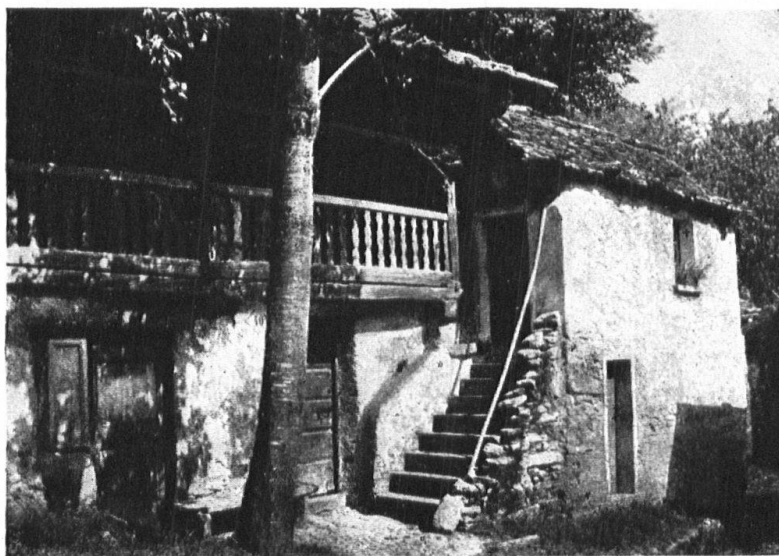
N° 12. Casa in Valle di Blenio con balconata e scaletta d'un bell'effetto decorativo. Abb. 12. Haus im Bleniothal, mit Balkon und äusserer Stiege von hübscher dekorativer Wirkung.
