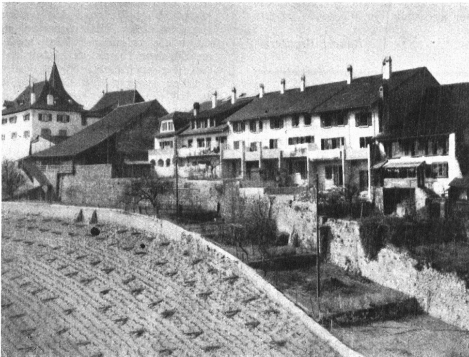
Abb. 11. Die Altstadt von Erlach seit dem Wiederaufbau von 1921. Harte und einförmige Wirkung der neuen Architektur. — Fig. 11. Cerlier, l'ancienne ville depuis sa reconstruction en 1921. Architecture aux lignes monotones et sans grâce.
