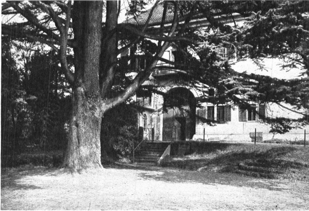
Abb. 4. Blick unter der Zeder durch auf einen Teil der Südfront. — Fig. 4. Le cèdre et une partie de la façade sud.
