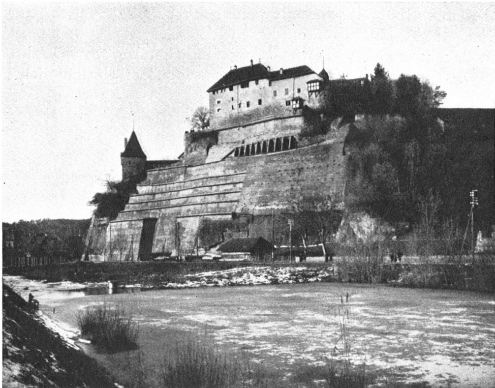
Abb. 11. Der Schlossfels nach vorläufiger Beendigung der Stützbauten. Der jüngere Teil zeigt Terrassen, die sich dem Felsen anschmiegen; gelingt die Bepflanzung, so mag dann diese Partie besser aussehen als der Zementblock rechts. Aufnahme von H. Weber, Zürich. — Les falaises du château. Etat actuel et provisoire des travaux de consolidation. Dans la partie la plus récente, au fond, on distingue des terrasses qui s'adaptent aux formes du rocher. Si l'on réussit à y faire croître de la végétation, elle produiront peut-être un effet moins laid que les énormes blocs de ciment de droite. Cliché de M. H. Weber, Zurich.
