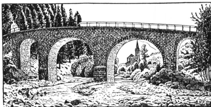
Fig. 15. Viaduc à Fiesch de la ligne de la Furka. D'après un dessin à la plume de P. Colombi. Le fait d'être construit sur une courbe de la voie enlève à cette série de pleins cintres toute monotonie. — Abb. 15. Fiescher-Viadukt der Furkabahn. Nach einer Federzeichnung von P. Colombi. Die gleichmässigen Bogen wirken nicht eintönig, da die Brücke eine Kurve beschreibt.
