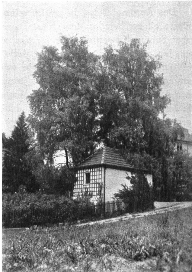
Abb. 1. Autogarage in Zollikon (Zürich). Durch den Garten von dem, der Strasse fernstehenden, Wohnhause getrennt. Einfache, gute Lösung. Besitzer Dr. J. Frölich. — Fig. 1. Garage à Zollikon (Zurich), séparé par un jardin de la maison d'habitation, qui est elle-même éloignée de la route. Exemple simple et de bon goût. Dr. J. Frölich, propriétaire.
