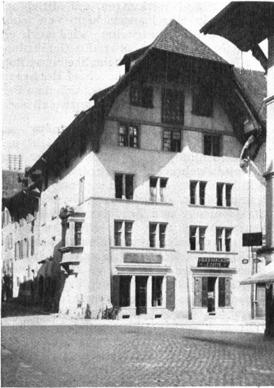
Abb. 20. Das Weibezahlhaus in Aarau, vor dem Umbau. Charakteristisch der Mittelpfeiler, zwischen den später entstandenen Magazinen der Hauptfront.
