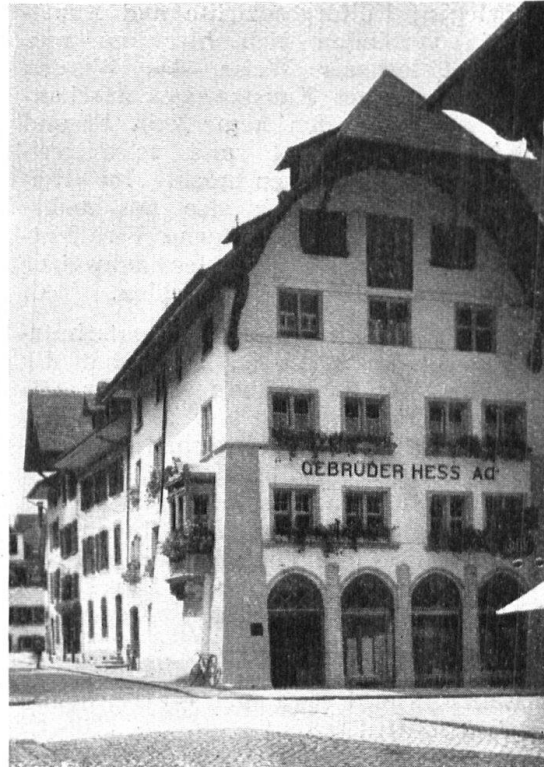
Abb. 21. Das Weibezahlhaus in Aarau, nach dem Umbau. Die Schaufenster sind mit Geschick eingebaut, allerdings der Mittelakzent geopfert. Gut angebrachte Firmenschrift. Photo W. Hergert. — Fig. 21. Le Weibezahlhaus à Aarau, après la restauration. Les devantures du magasin ont été habilement réparties entre les piliers. Le nom de la maison de commerce a été mis avec goût.
