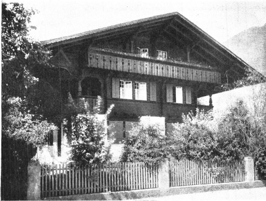
Abb. 10. Neues Chalet in Interlaken. Arch. Vifian & von Moos. Die charakteristischen Verhältnisse und Formen der guten alten Vorbilder sind in neuem Sinne verwendet. — Fig. 10. Chalet moderne à Interlaken. Vifian & von Moos, architectes, qui ont tiré un excellent parti des meilleures formes et proportions de l'architecture locale.
