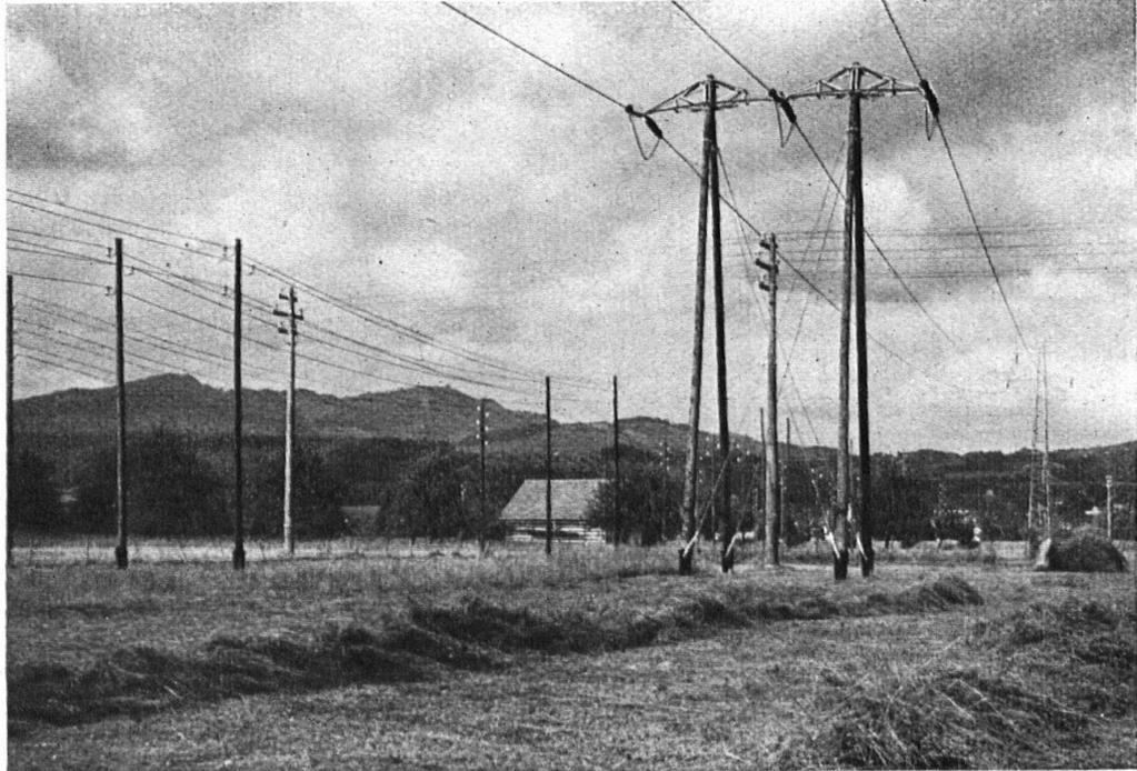
Abb. 3. Hoch- und Höchstspannungsleitungen bei Grynau. Rechts im Bilde 135 kV-Leitung auf, durch Eisen-
