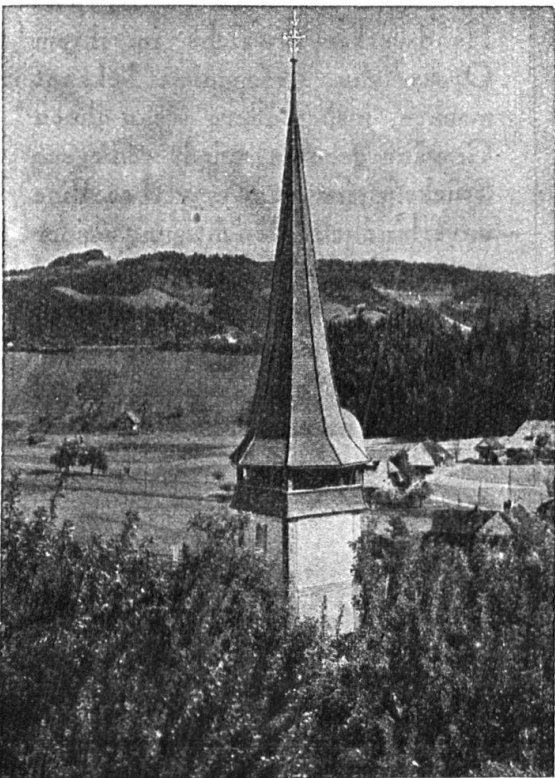
Kirchturm in Signau ETERNIT-DOPPELDACH, KUPFERBRAUN ETERNIT NIEDERURNEN
