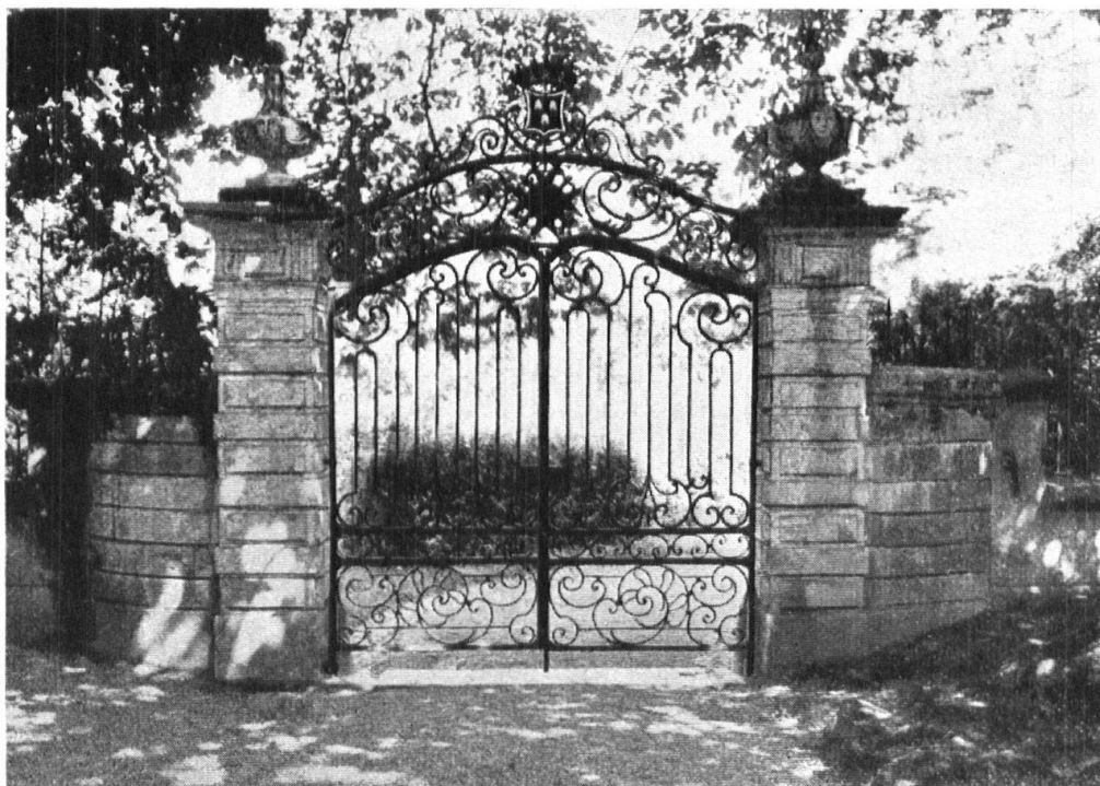
Abb. 4. Das Zurückweichen der seitlichen Flügelmauern nach dem Garten hin erhöht die Wirkung des Portales mit dem eleganten Eisengitter und den Postamenten in Berner Barock (von Burenstock, Bern). Aufnahme Albert Stumpf, Bern. — Fig. 4. Les murs de clôture, rentrant vers le jardin des deux côtés du portail, rehaussent l'effet de celui-ci et mettent mieux en valeur l'élégance de la grille en fer forgé et des piliers de style baroque bernois (von Burenstock, Berne). Cliché d'Albert Stumpf, Berne.
