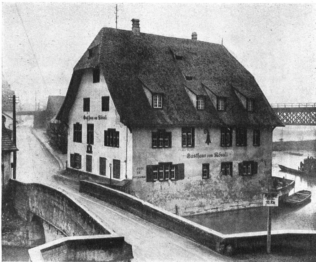
Abb. 2. Das Gasthaus „zum Rössli“ (ehemaliges Zollhaus) an der Ergolzbrücke zu Augst, vor dem Umbau. Zu beachten der Verfall der Mauern, die zu hohen neueren Dachlichter, welche die schöne Linie des Daches unterbrechen. — Fig. 2. L'hôtel « zum Rössli » (ancienne Douane) et pont d'Augst, avant la rénovation. Les murs sont décrépis, les lucarnes, ajoutées plus tard, et trop hautes, apportent une note discordante dans les belles lignes du toit.
