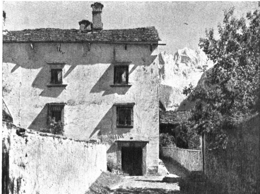
Abb. 1. Im Bergell. Eines der Salishäuser, genannt Casa Gubert, in Soglio. Photographie Albert Steiner, St. Moritz. — Fig. 1. Dans le Bergell. Une des maisons Salis, dite Casa Gubert, à Soglio. Cliché d'Albert Steiner, à St. Moritz.
