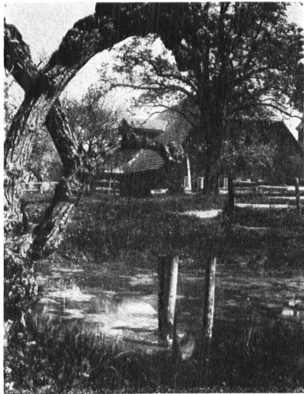
Abb. 12. Guter Feuerweiher in Schlosswil, Kanton Bern, dem die Feuerwehrkommission die Tauglichkeit abgesprochen hat. Durch Vertiefung, hölzerne Uferbefestigung und Auslauf wie bei Abb. 2 könnte er allen Ansprüchen genügen. — Fig. 12. Bon étang à Schlosswil, canton de Berne.
