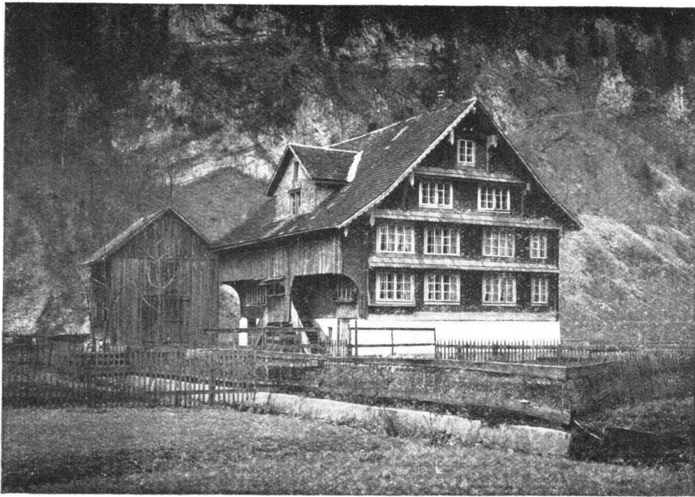
Abb. 5. Bauernhaus in Iberg (Schwyz). Wieder kein Walmdach, dafür Klebdächer. Die Gegend hat kein Getreide, nur Wiesen und Weiden, daher wenig Dachraum. — Fig. 5. Maison paysanne à Iberg (Schwyz). De nouveau un toit à deux pans seulement, mais des auvents protègent les fenêtres. La contrée ne connaît pas la culture du blé, on n'y rencontre que des prairies et des pâturages; aussi ne reste-t-il guère de place perdue sous les combles.
