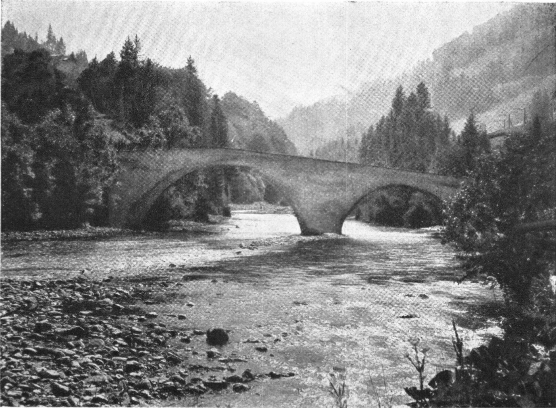
Abb. 5. Alte Steinbrücke über die Saane, Kanton Freiburg. Verschieden grosse Öffnungen, den Gründungsverhältnissen angepasst, der Scheitel über dem höhern Bogen. — Fig. 5. Vieux pont de pierre sur la Sarine, canton de Fribourg. Arches de grandeurs différentes, dont les dimensions sont déterminées par la nature des fondations. La plus grande arche marque le sommet du pont.
