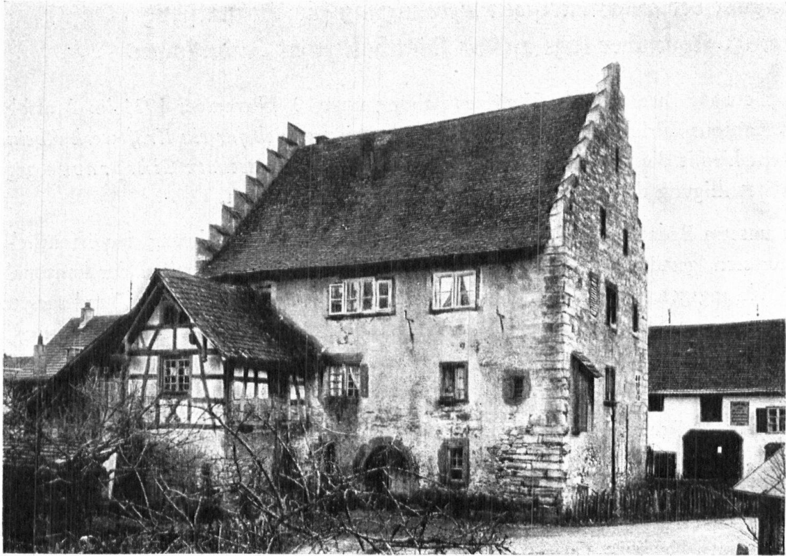
In Rheinau finden wir mehrere ritterbürtige Häuser des Mittelalters mit Treppengiebeln, hier dasjenige der Wellenberg. — A Rheinau il y a plusieurs maisons à pignon en escalier datant du Moyen-Age; voici celle des chevaliers Wellenberg.
