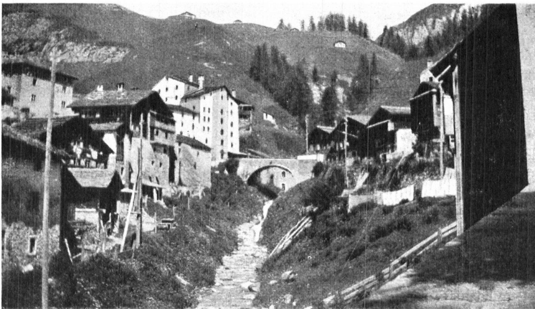
Der Dorfbach. Links neben der Brücke die Häuser von Schorsch und von Albertini. Le ruisseau du village avec les maisons von Schorsch et von Albertini.
