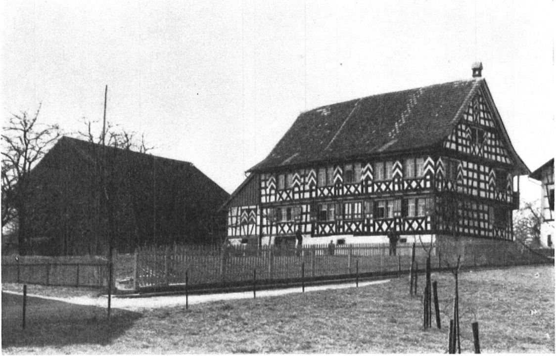
Kreisgerichtshaus in Zihlschlacht.
