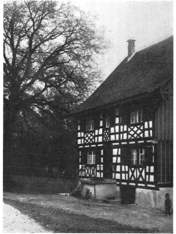
Riegelhaus in Mallisdorf.
