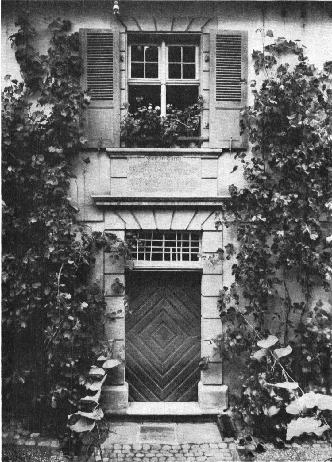
Entrée de la Cure de Binningen près Bâle qu'on veut démolir, personne ne sait pourquoi.
