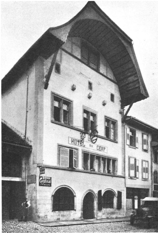
Estavayer. L'hôtel du Cerf avant sa restauration. — Stäffis am See. Gasthaus zum Hirschen vor der Wiederherstellung. Aufnahme des Bürgerhauswerkes.
