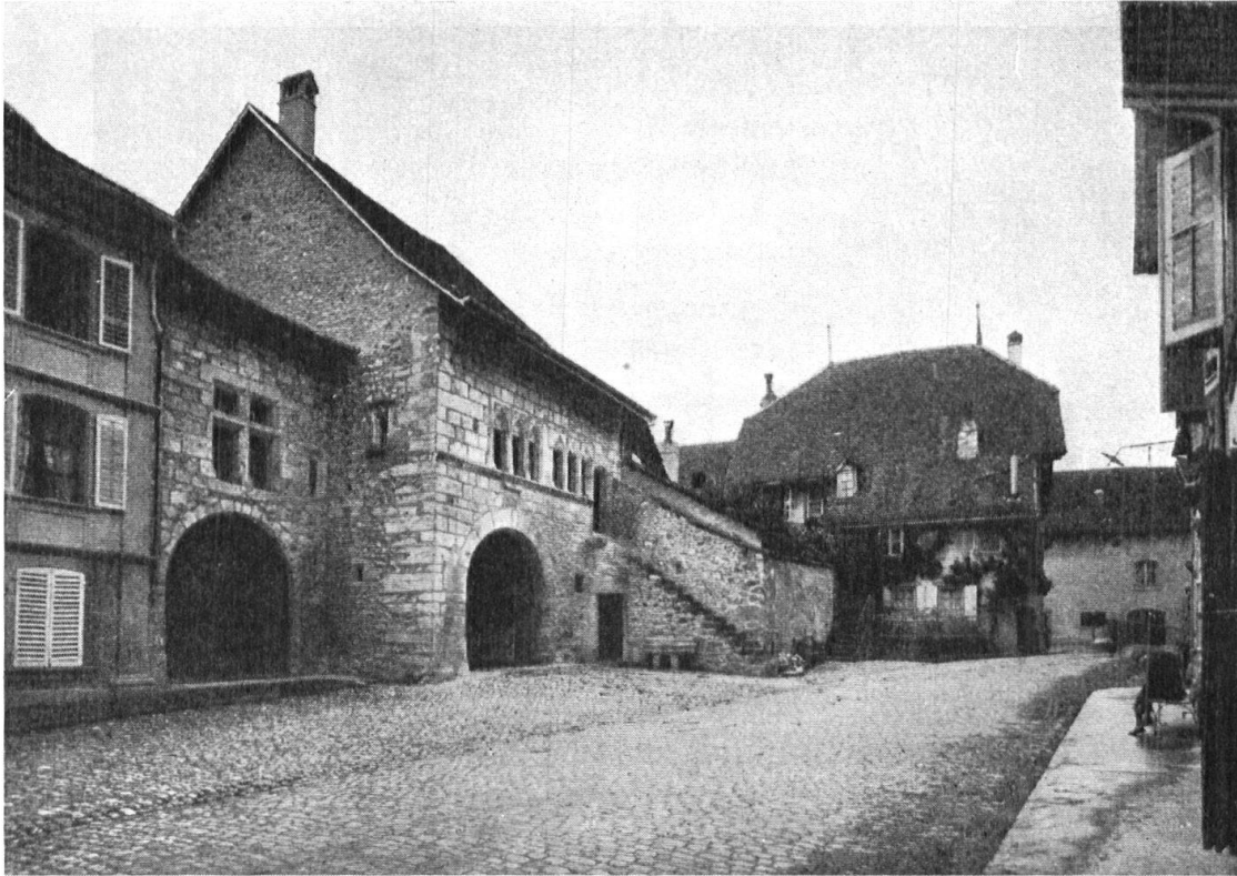
Estavayer. La maison du Dime restaurée. — Stäffis am See. Das erneuerte Zehntenhaus. Aufnahme des Bürgerhauswerkes.
