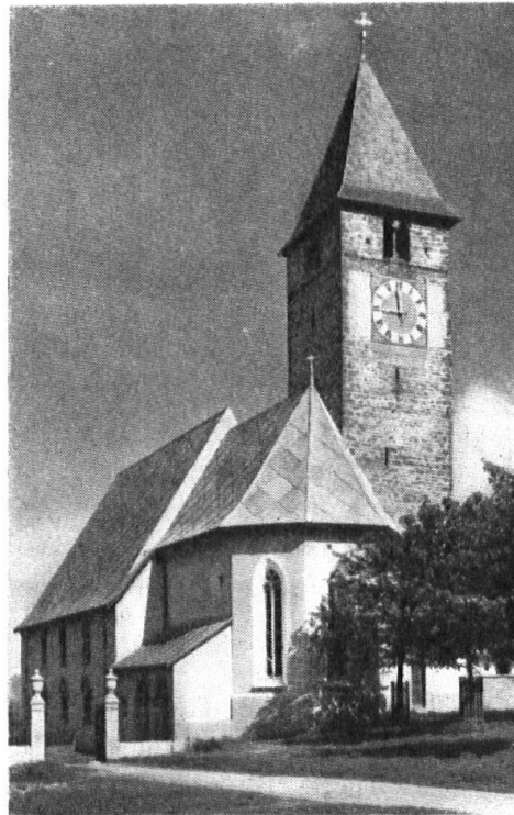
Kirche in Klosters. Alter romanischer Turm, Chor des bekannten Bündner Kirchenbau-meisters Andreas Bühler (um 1500), leider mit viel zu grossen Eternitplatten eingedeckt. An den Chorfenstern Glasbilder von Augusto Giacometti.
