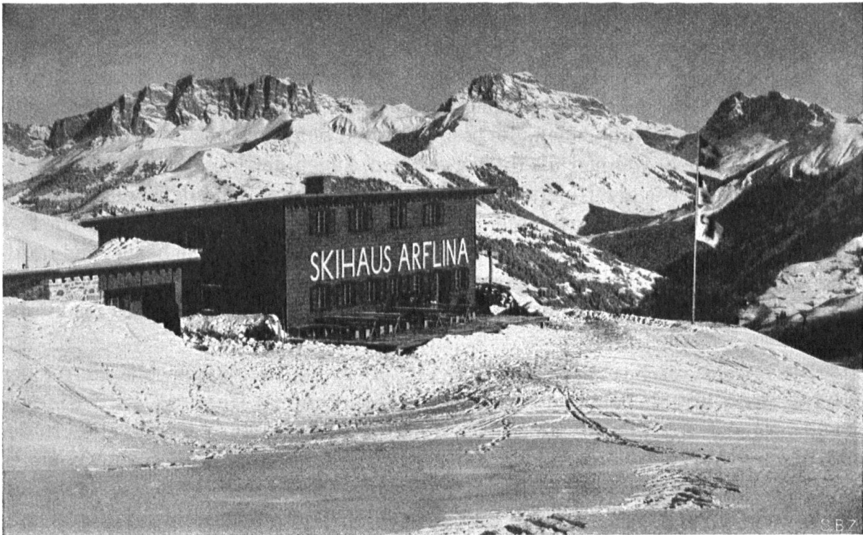
Skihaus Arflina in den Fideriser Heubergen, 1935. Skelettbau mit horizontaler Schalung. Bedachung Kupferblech. Einstöckiger Skiraum massiv. Rud. Christ, Arch. B. S. A., Basel. Cabane pour skieurs près de Fideris, Grisons. Construite en bois par R. Christ, architecte, Bâle. Couverte en tôle de cuivre. Le magasin pour les skis, à un étage, en pierre.
