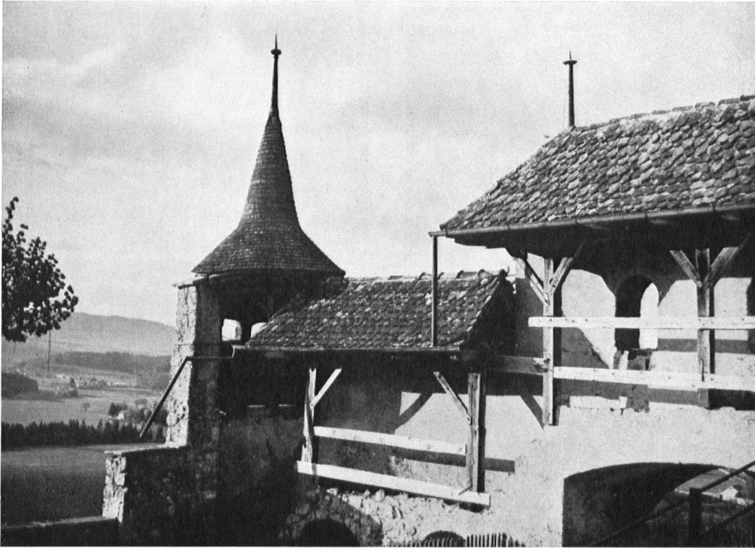
Le Belluard, ouvrage avancé du mur d'enceinte. — Stadtmauer von Greizerz.
